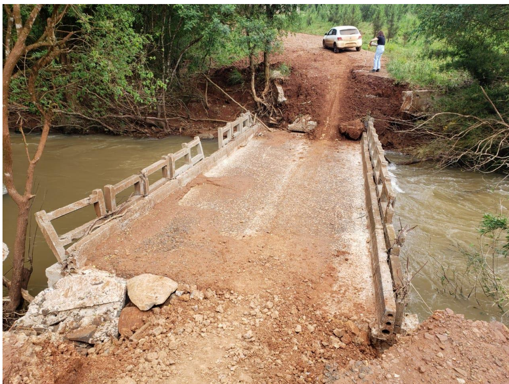
Figura 03: Cabeceira e estrutura comprometida que serão removidos – Lado Monte Carlo - SC
