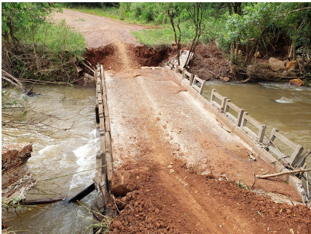
Figura 02: Estrutura que será removida por completo – Lado Frei Rogério - SC
